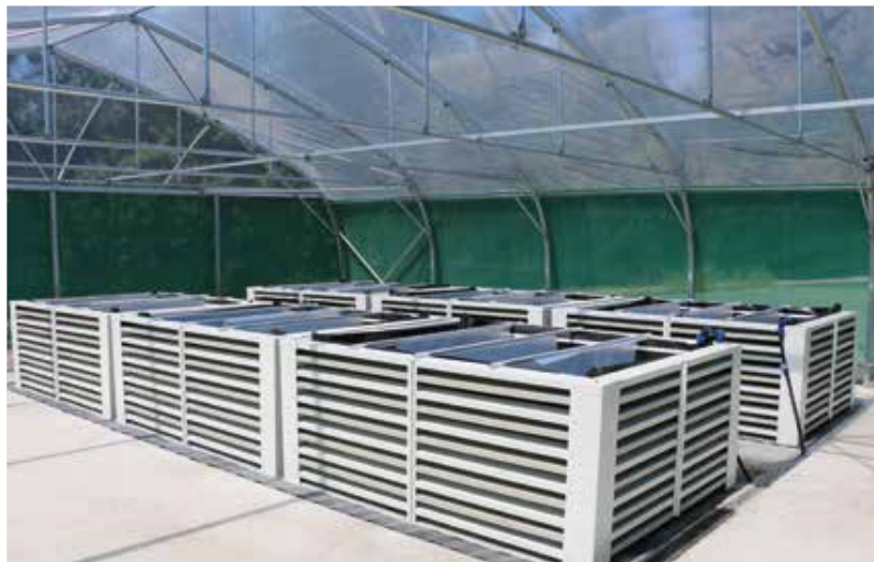
Le PhytoBarre est une installation de stockage capable d'accueillir les effluents phytosanitaires et les bactéries. La station arboricole expérimentale des Bouches-du-Rhône de La Pugère accueille un démonstrateur PhytoBarre de référence.
